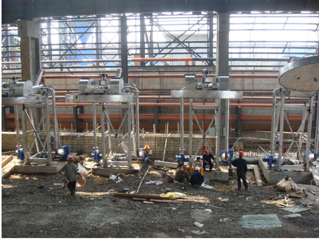
烤包器安装现场
